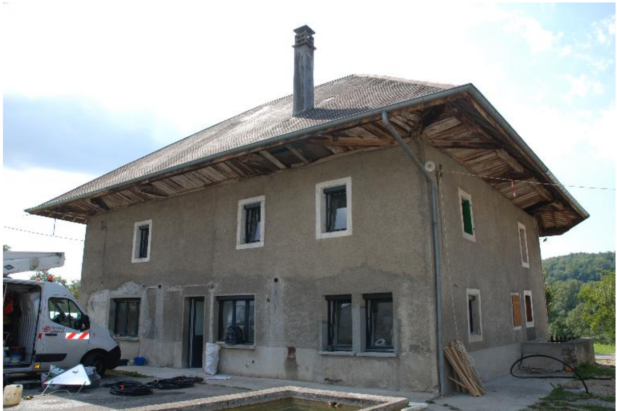
Vue de l'habitation, façades est et nord.
