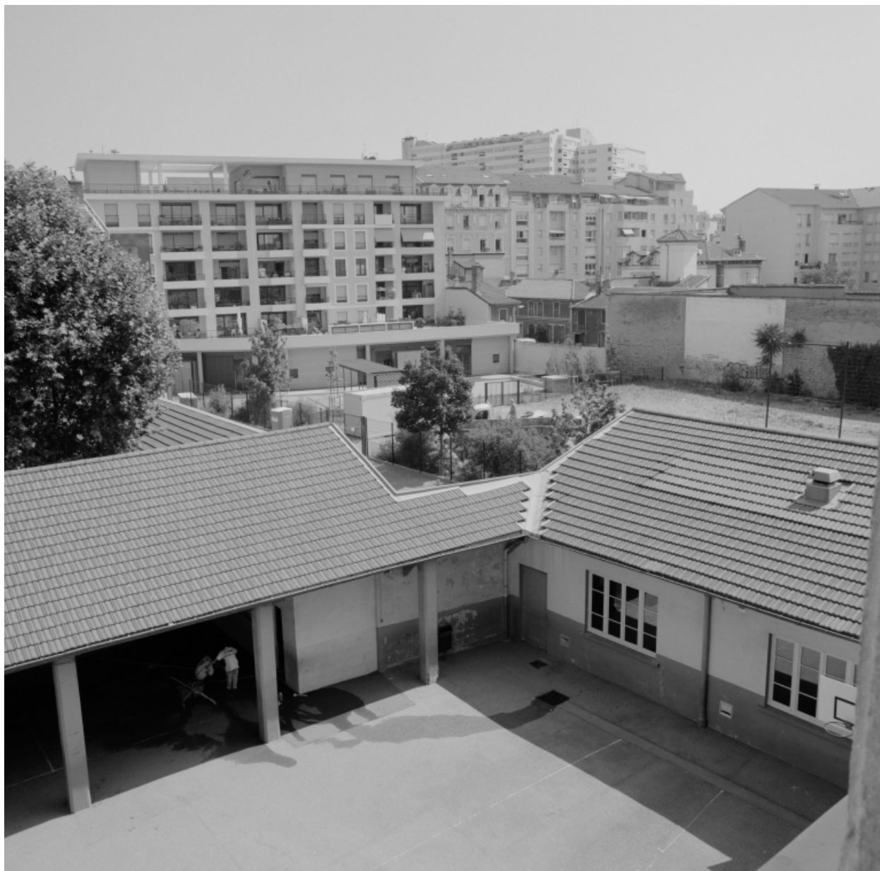
Cour centrale. Vue d'ensemble plongeante depuis l'ouest
