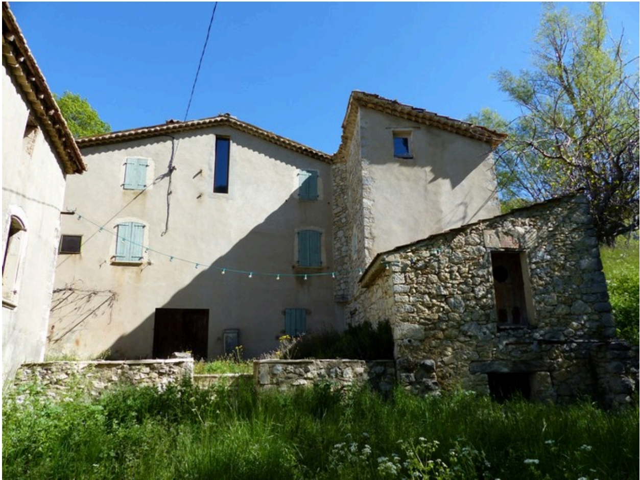
Bâtiment principal et extension sud-est. Vue d'ensemble prise du sud.
