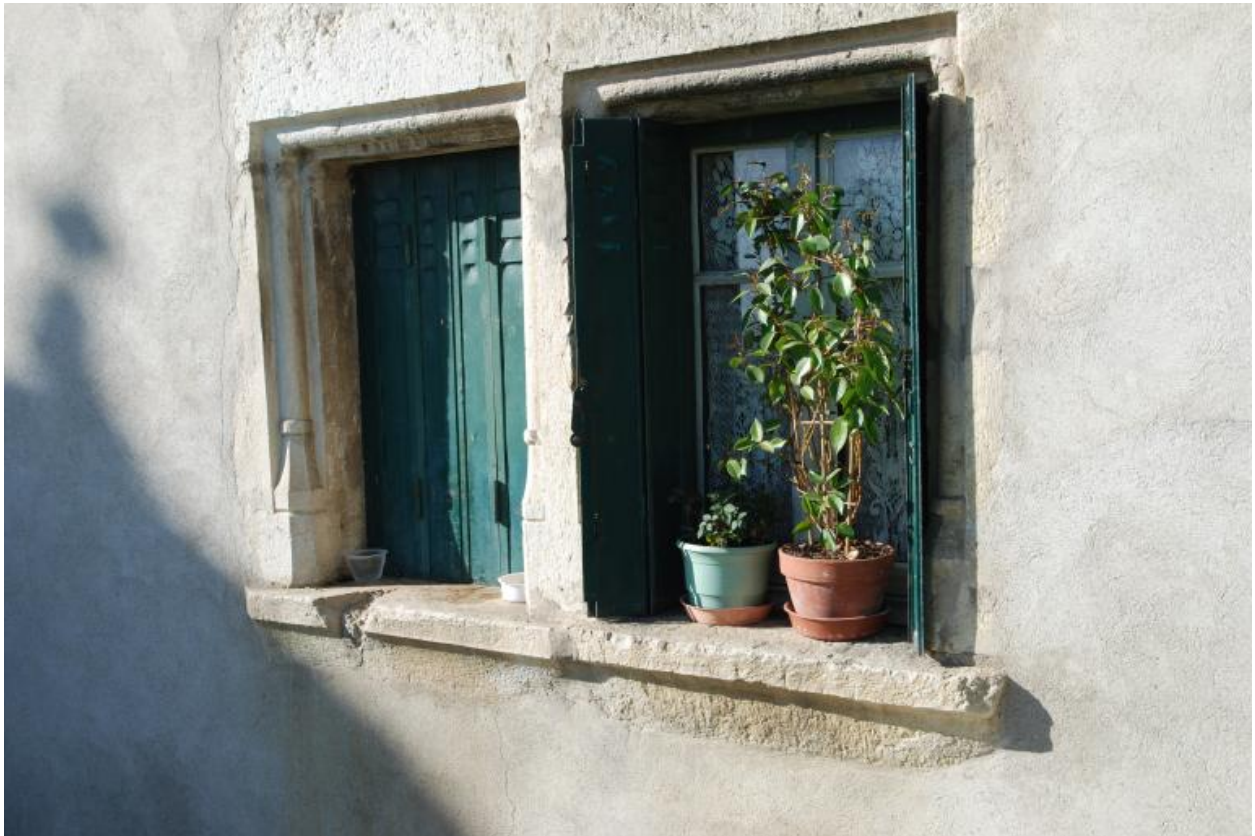
Façade principale sur cour, détail escalier et baies jumelées à gauche au rez-de-chaussée, détail.
