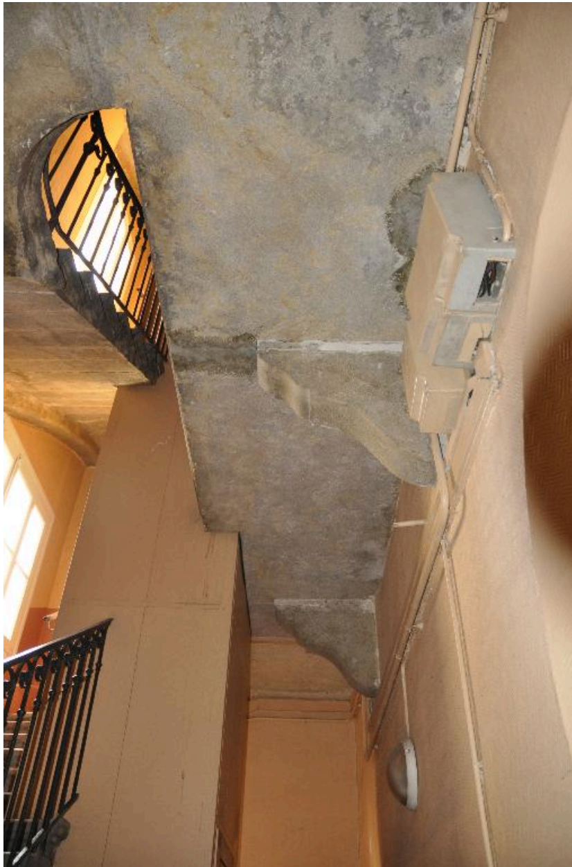
Vue de la cage d'escalier
