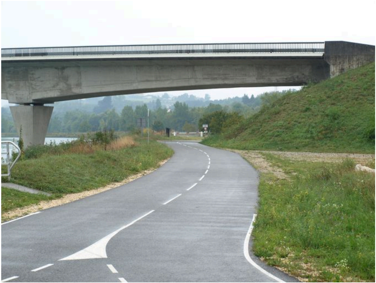
Travée de rive droite, face amont (depuis la rive droite)
