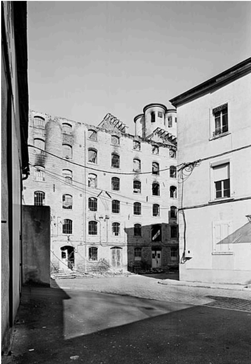
Vue sud du bâtiment principal qui a brûlé
