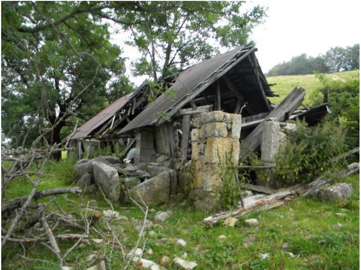
Vue de trois-quarts sud-ouest
