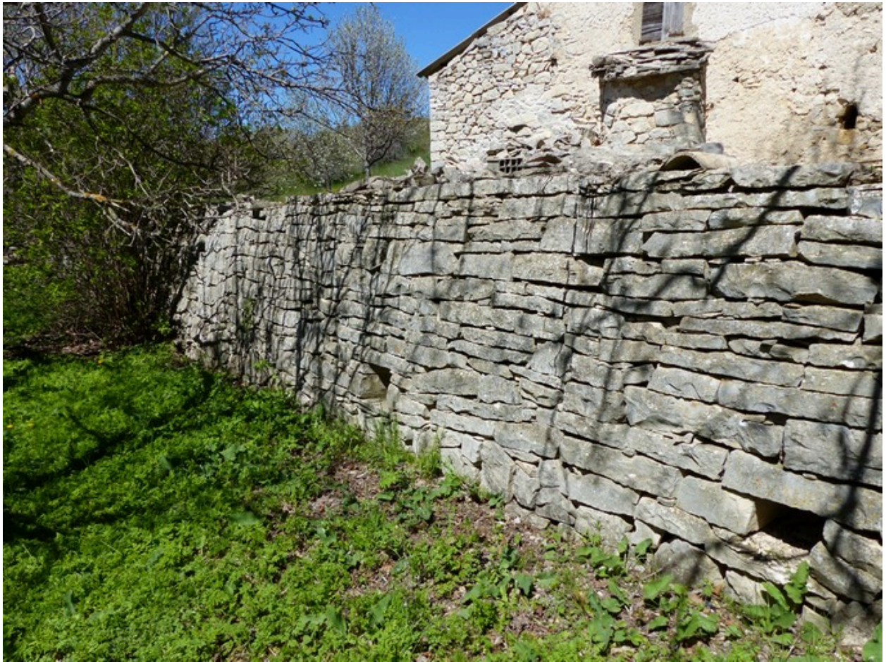
Jardin clôt. Mur de clôture.
