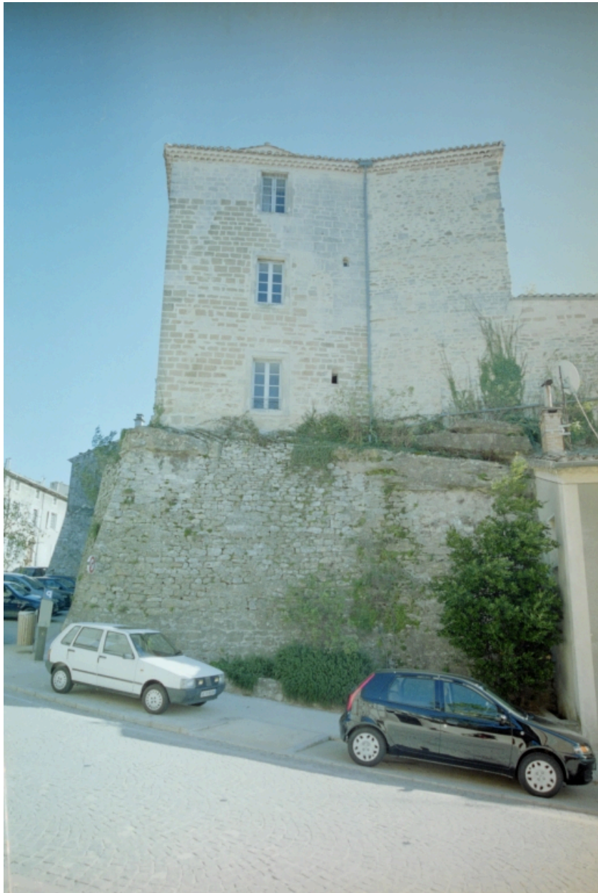
Elévations latérales sur la rue de l'Hôpital, au-dessus de l'ancienne enceinte.
