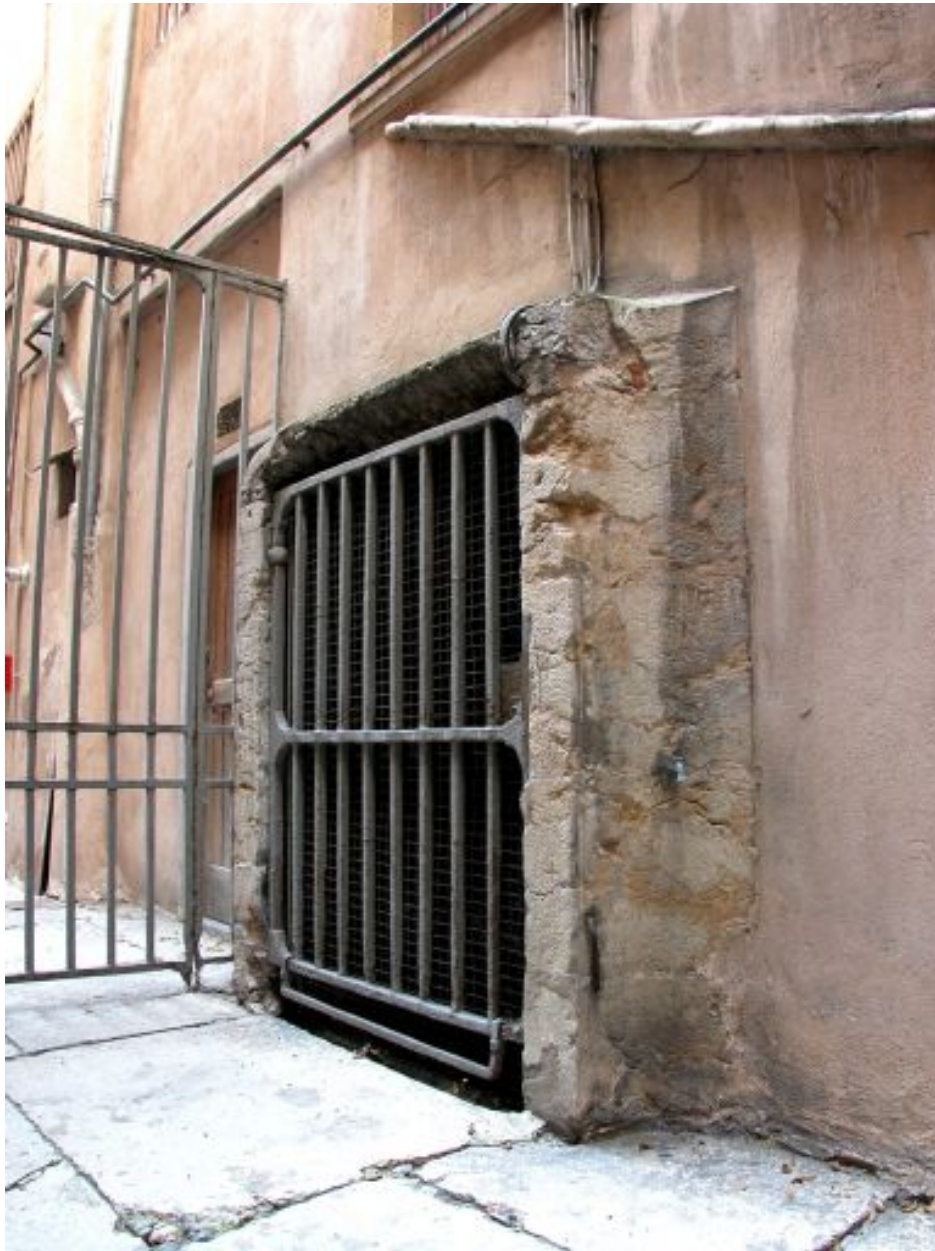
Cour, entrée de l'escalier du sous-sol
