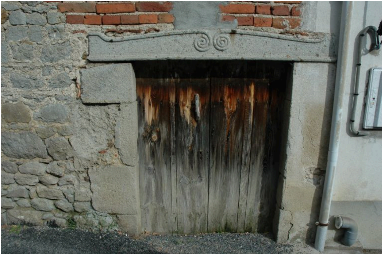
Détail porte avec linteau en remploi (linteau de cheminée du 18e siècle).
