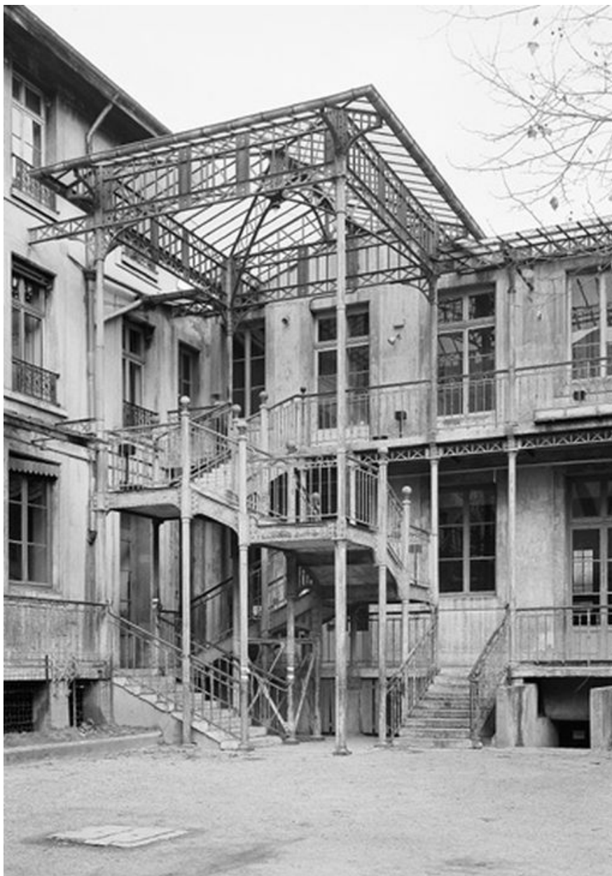
Ecole Ozanam, escalier hors-oeuvre desservant les étages depuis la cour
