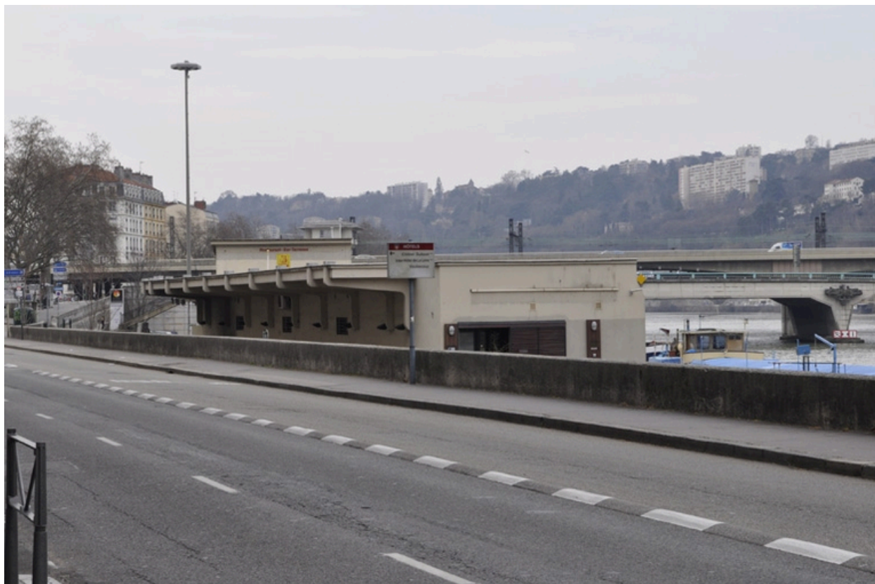
Vue nord : détail avant-toit du second bâtiment
