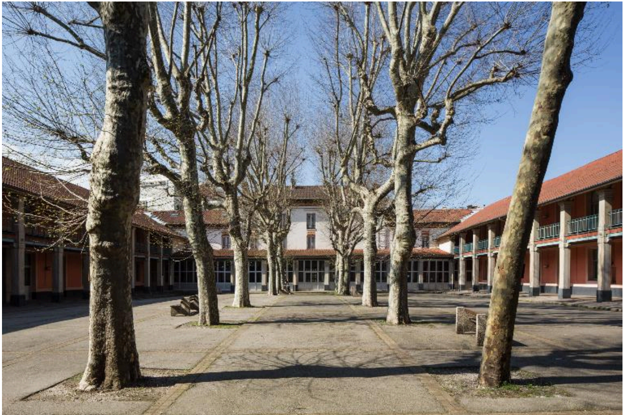
Vue sur cour intérieure du bâtiment A. Orientation nord-sud
