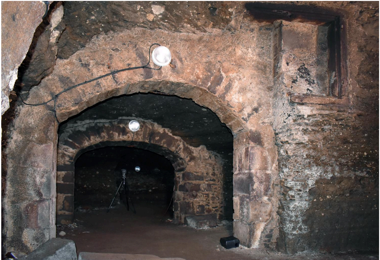
Caves sud, salle n°3 : détail des éléments de fenêtre en remploi
