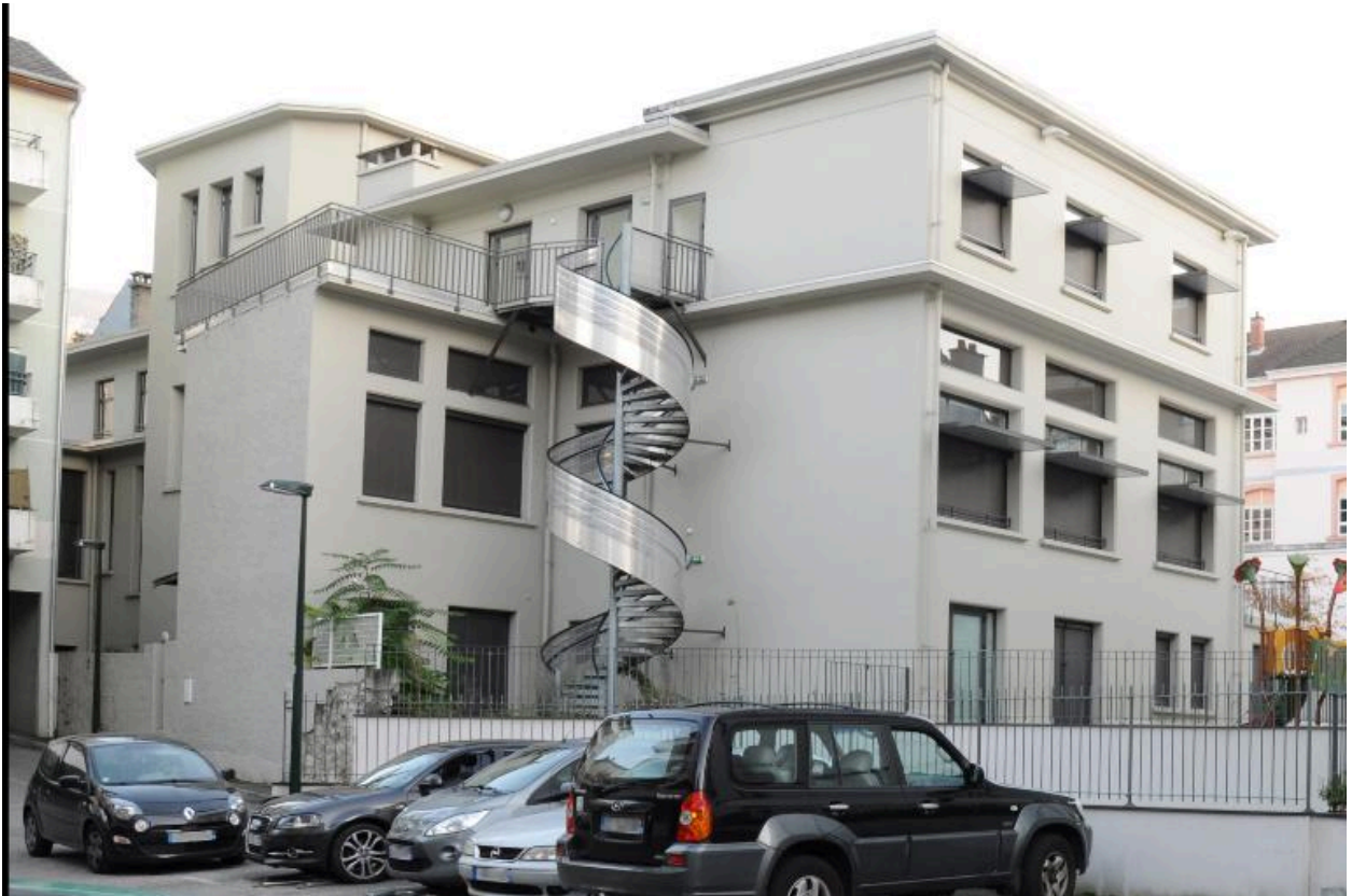
Façades postérieure (nord) et latérale (ouest)
