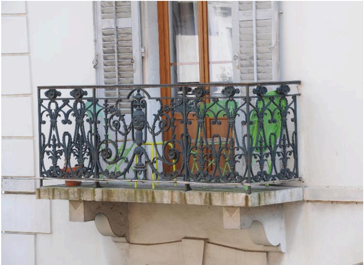
Balcon au 1er étage
