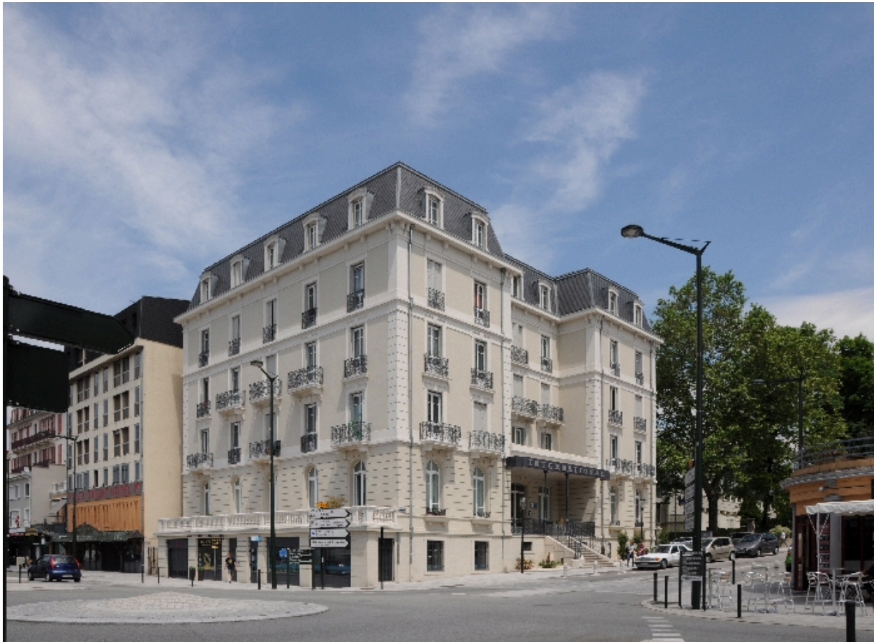
Vue de trois-quart depuis le sud-ouest
