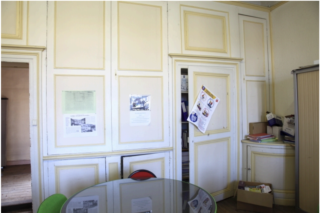
Bâtiment A, 1er étage. Greta. Bureaux sur l'aile orientale. Lambris et portes.
