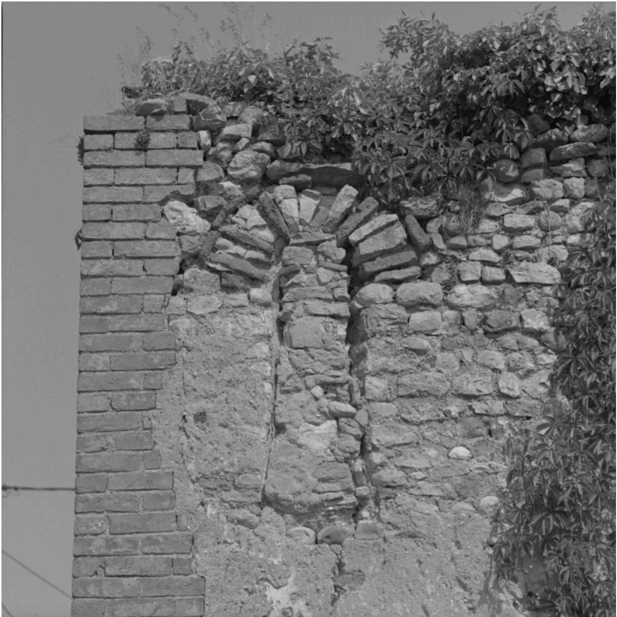
Détail : baie en plein cintre, au-dessus de l'arc de l'ancienne chapelle.
