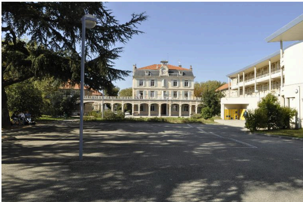
Vue générale depuis l'est
