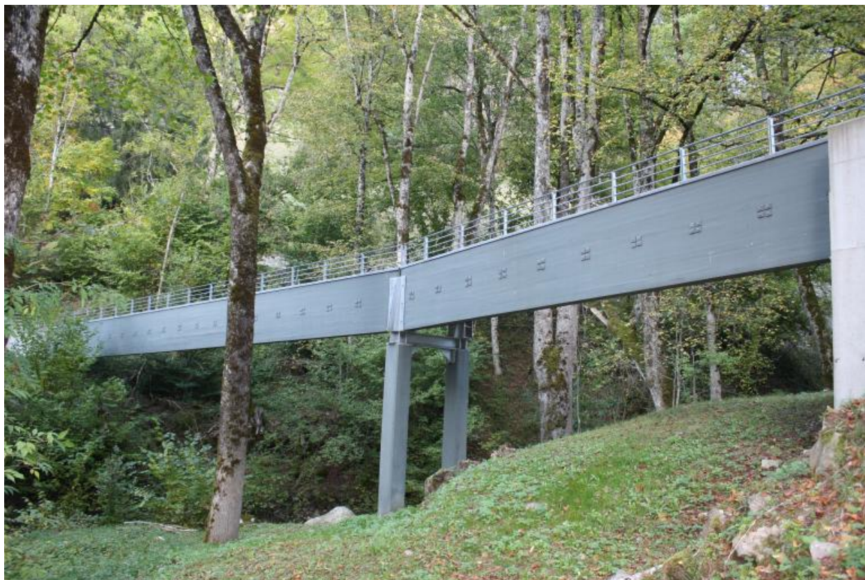
Passerelle de l'Abbaye d'Aulps, face aval
