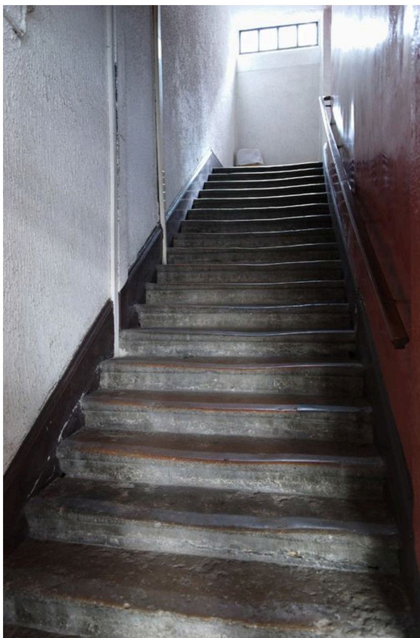
Première volée de l'escalier
