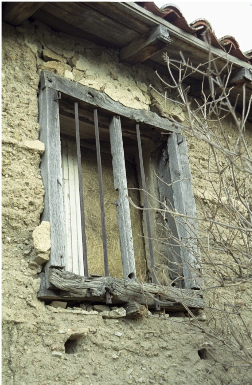
Saint-Sixte, Ciergues, bâtiment agricole (1987 D3 955). Baie à croisée.
