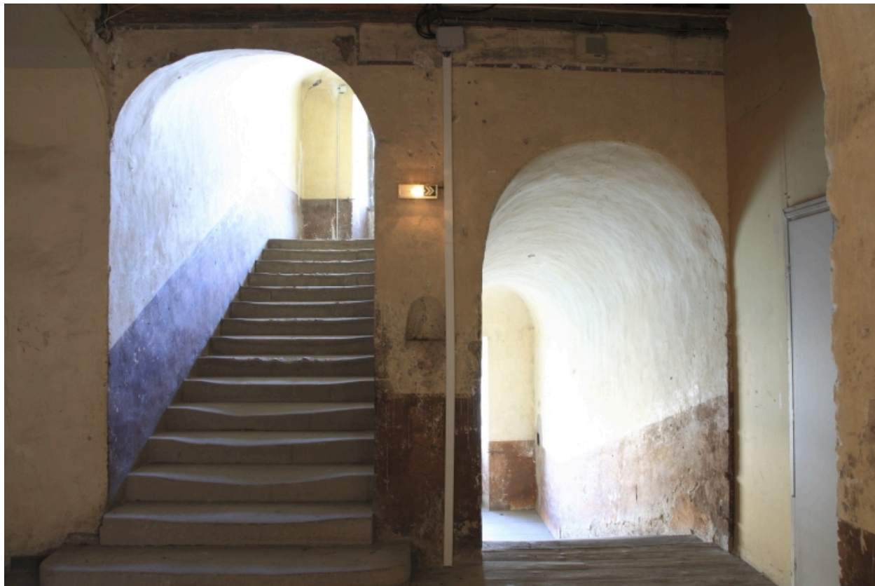
Bâtiment A. Escalier nord-est. Palier du 2e étage.
