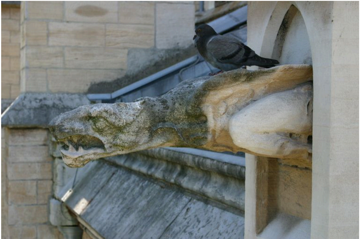
Gargouilles situées à l'angle des élévations nord et ouest : gargouille nord
