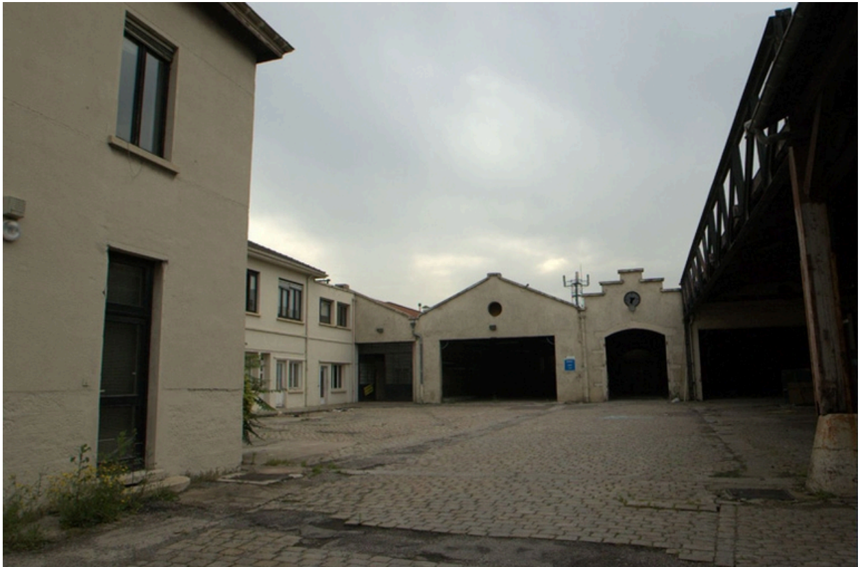
Ateliers et bâtiment administratif, vue sud-ouest
