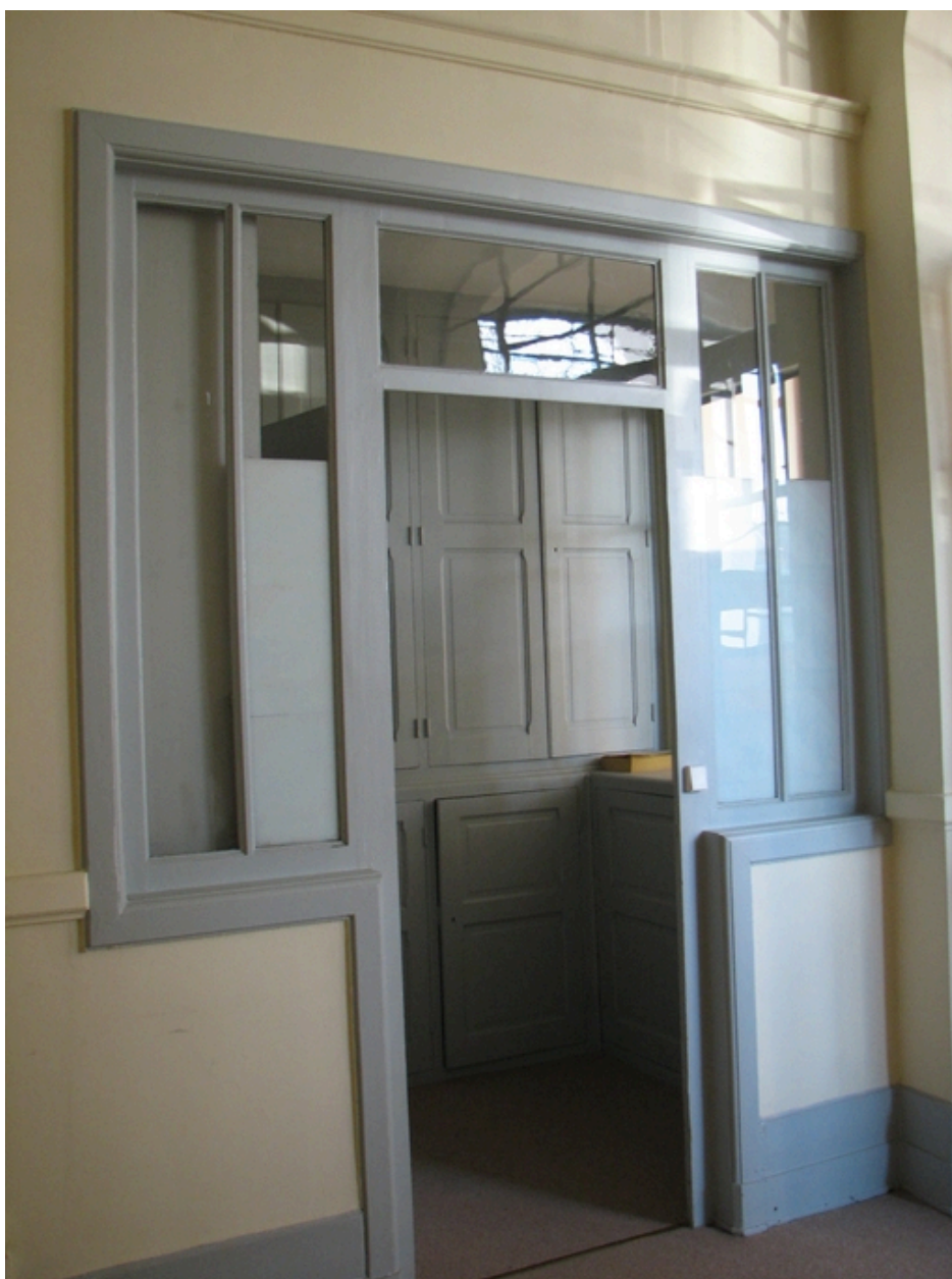
Porte des grands bureaux
