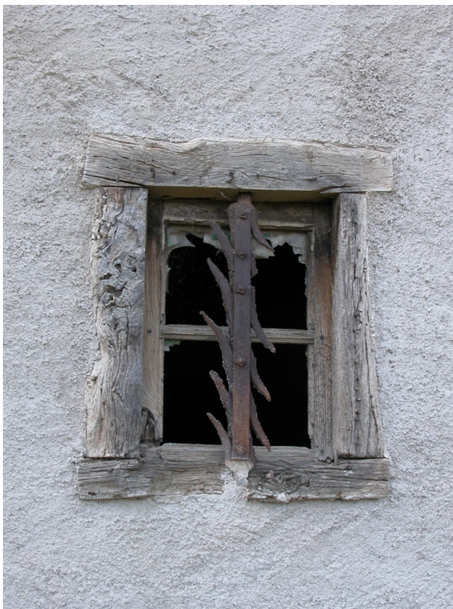
Détail d'une fenêtre à barreau en fer forgé découpé (aragne).
