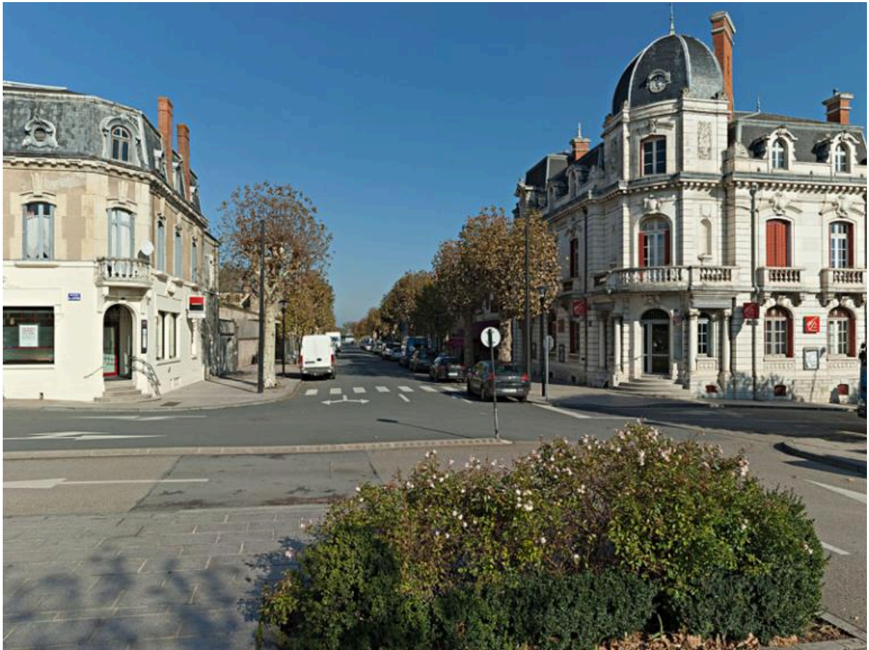
Saint-Pourçain-sur-Sioule (Allier). Avenue Pasteur. Une des rares tours d'angle de la région, au débouché de l'avenue menant à la gare (actuellement désaffectée, réutilisée en lycée). Elle concurrence un simple pan coupé avec balcon.
