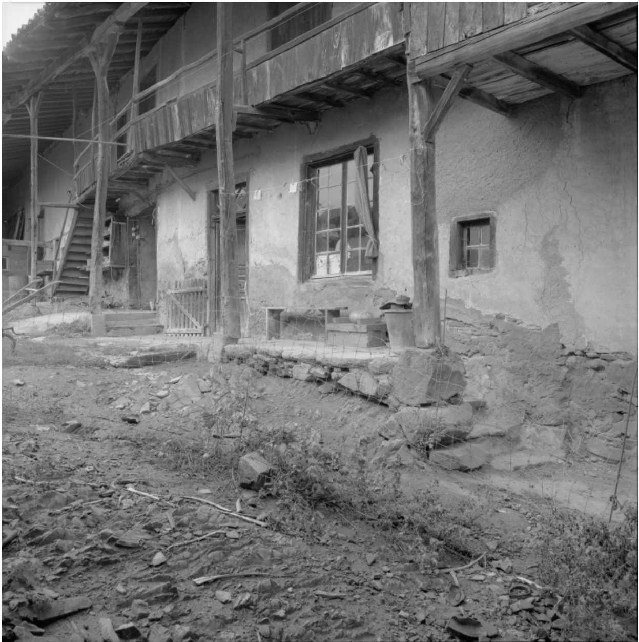
Elévation antérieure du logis, de trois-quarts, depuis la cour.
