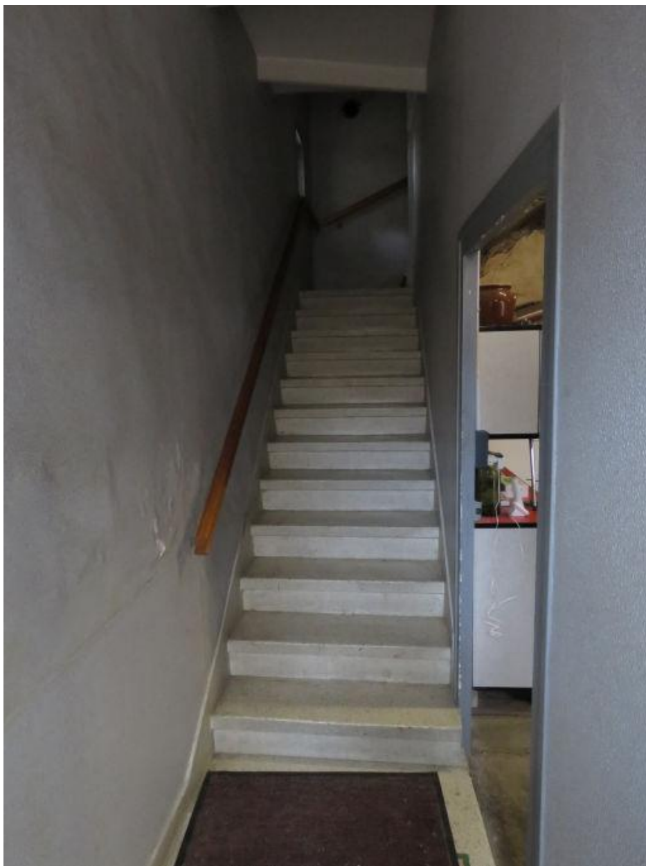
Vue intérieure : escalier
