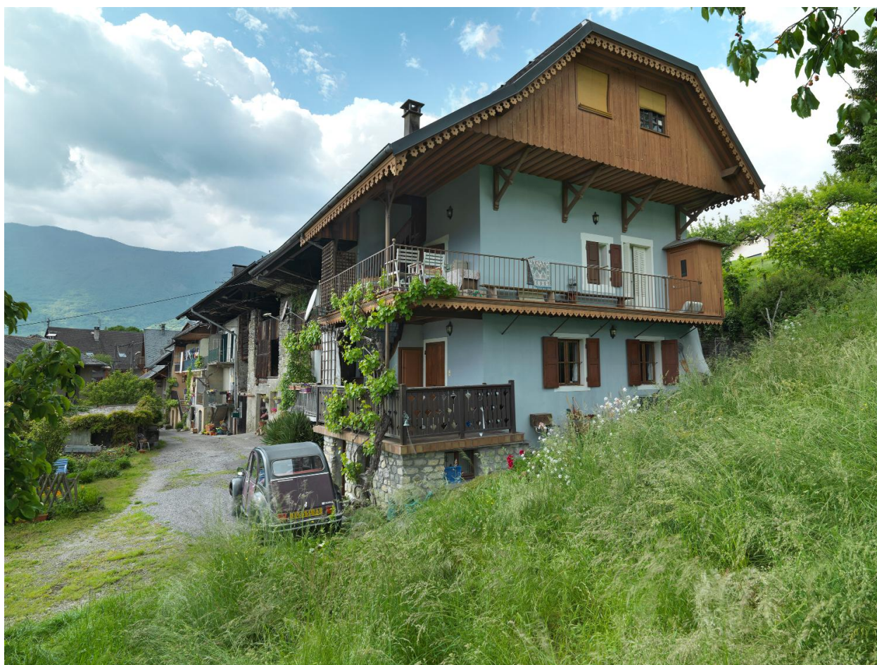
Vue générale depuis l'est.
