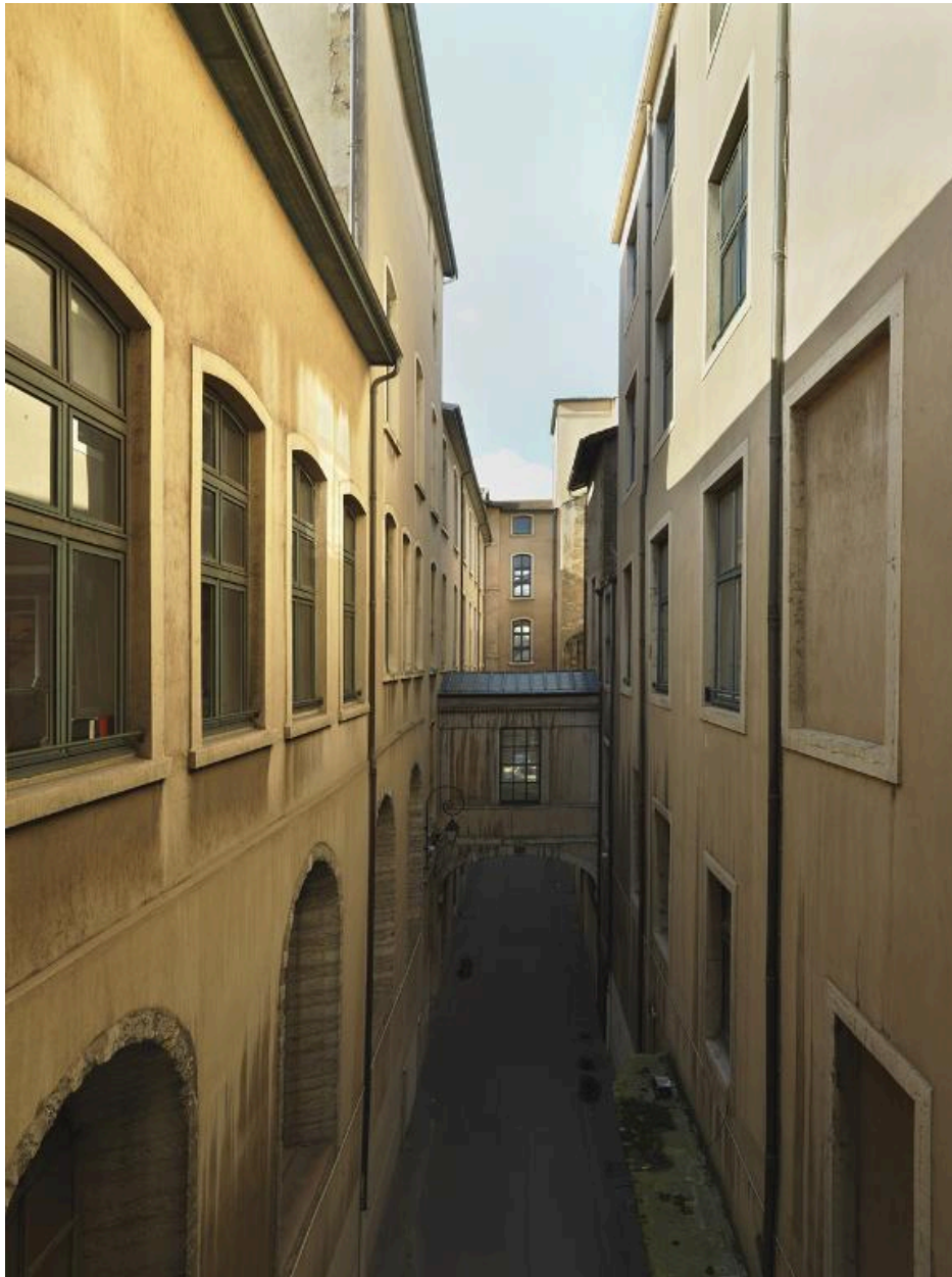
Passage Ménestrier vue d'ensemble depuis l'est
