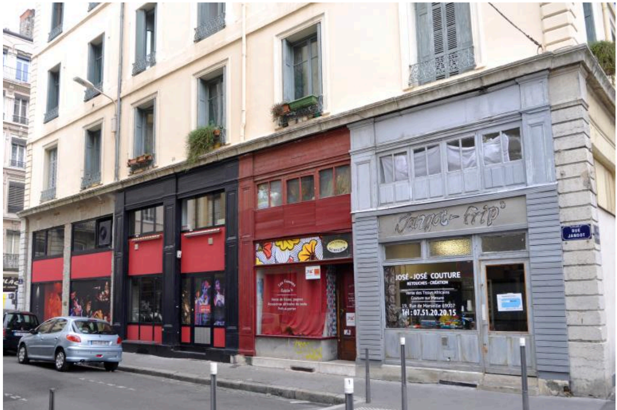
Elévation sur la rue Jangot, vue rapprochée du rez-de-chaussée
