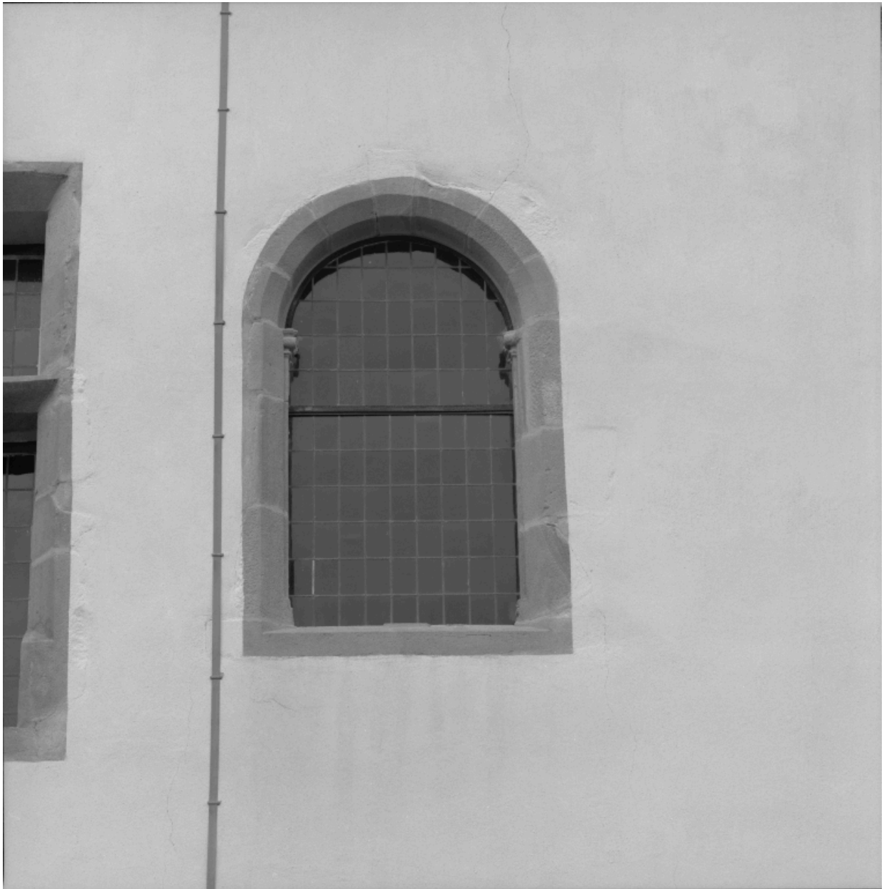
Façade sur jardin du corps de logis : détail d'une baie couverte en arc en plein cintre.
