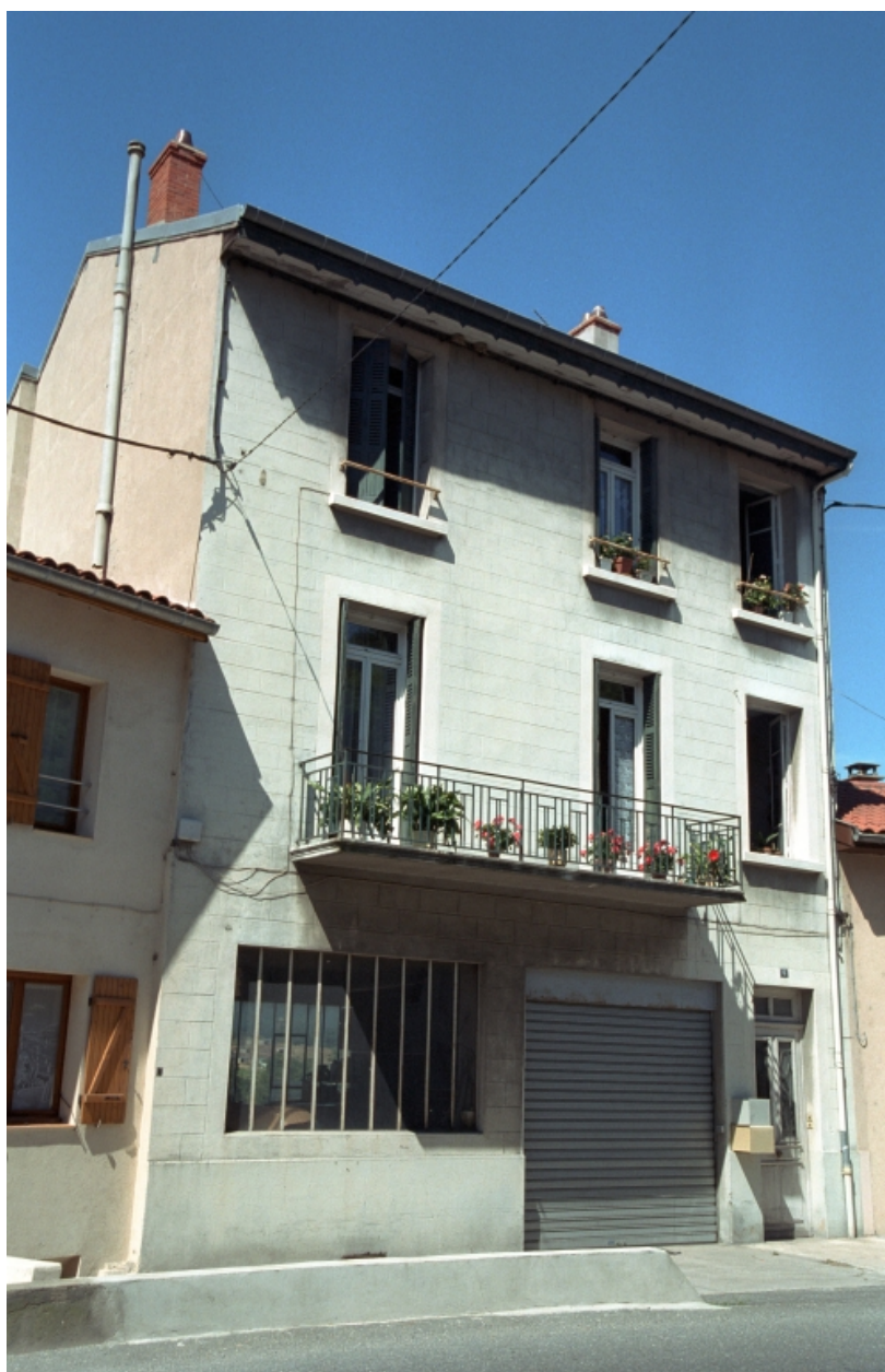
Boën, îlot 12, Clermont (rue de) 6. Vue générale de la façade sur rue.
