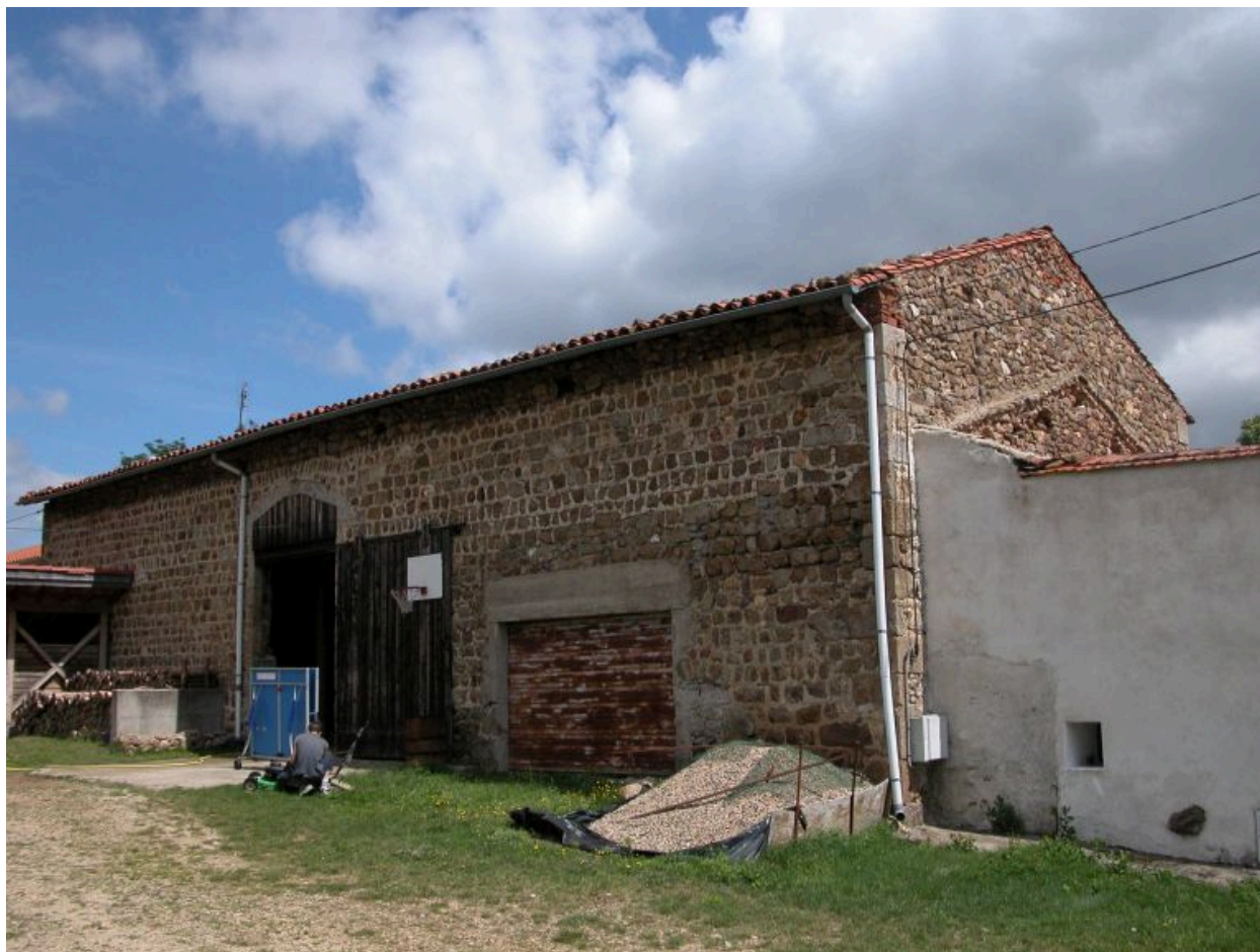
Vue d'ensemble de la grange-étable.
