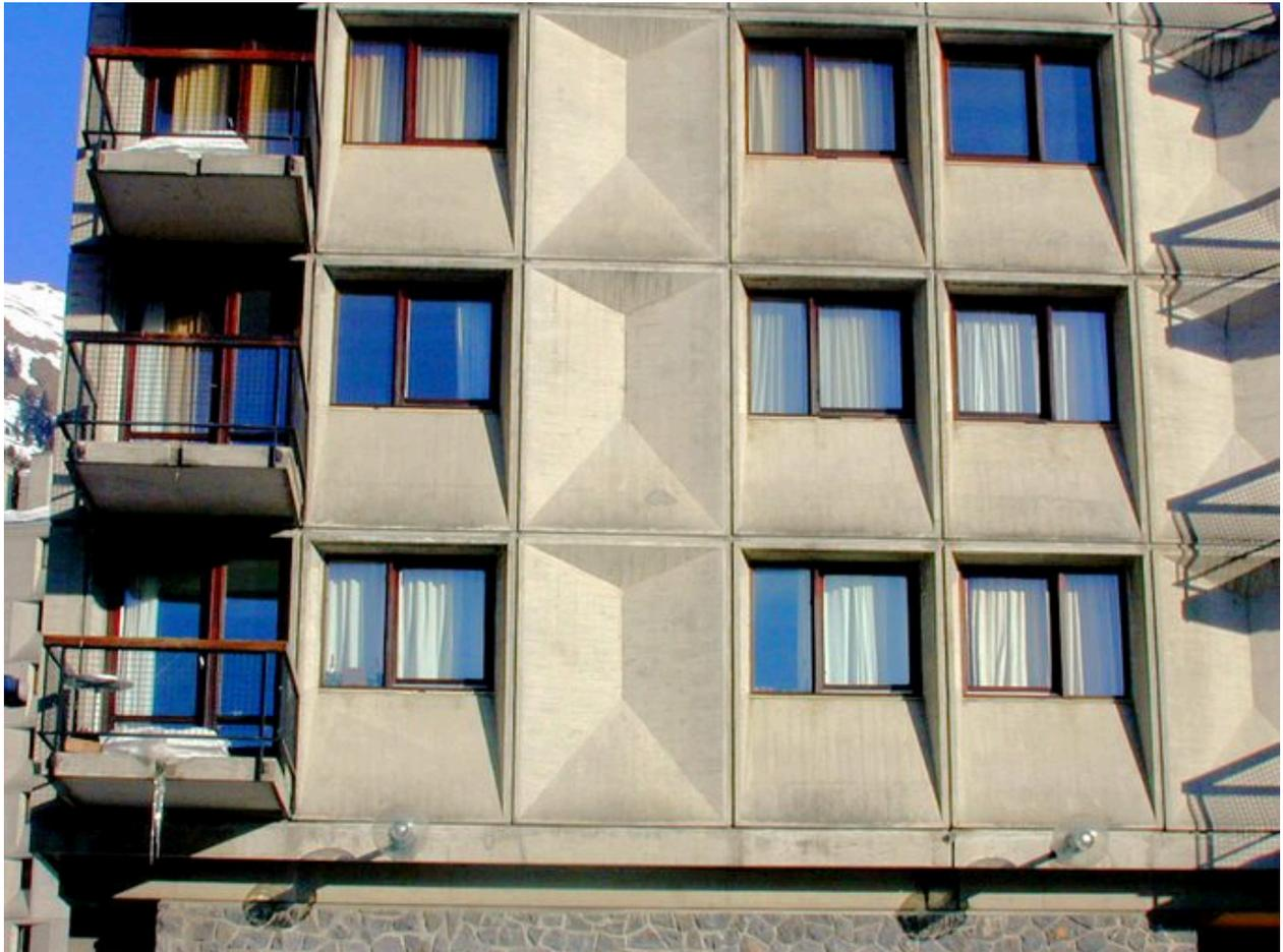
Façade ouest. Détail des fenêtres et des panneaux de béton préfabriqué.
