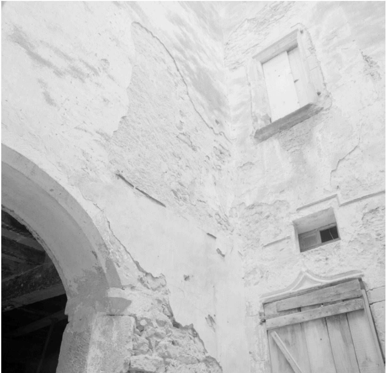
Cour intérieure, corps sud et ouest, élévation partielle. Détail de l'arc chanfreiné et de l'imposte taillée en culot.
