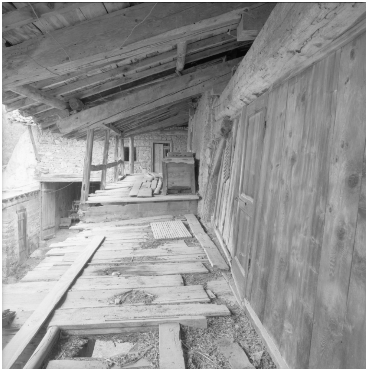
Vue de la galerie en enfilade, depuis le nord.
