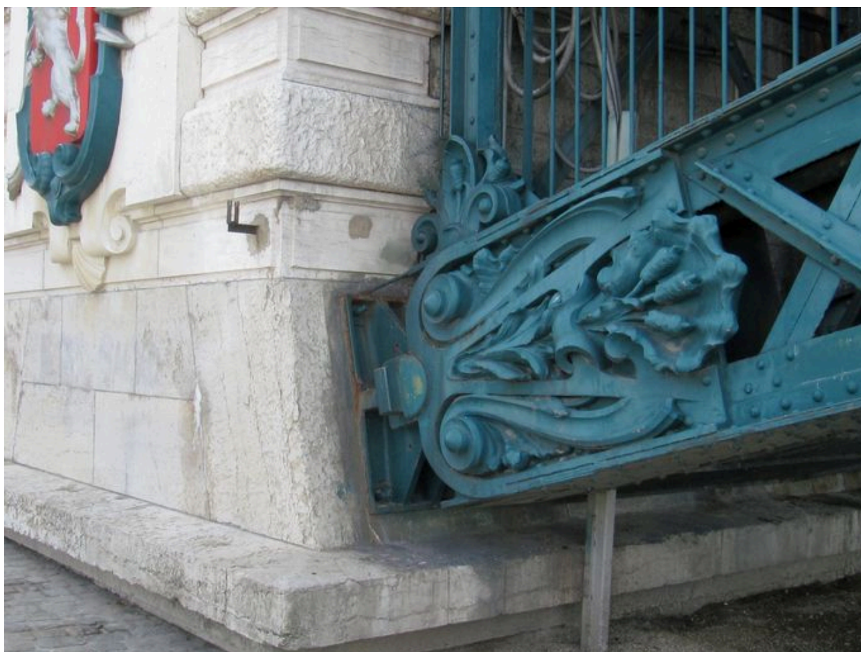
Pile de rive, face amont, vue de détail : ancrage de l'arche (depuis la rive gauche)
