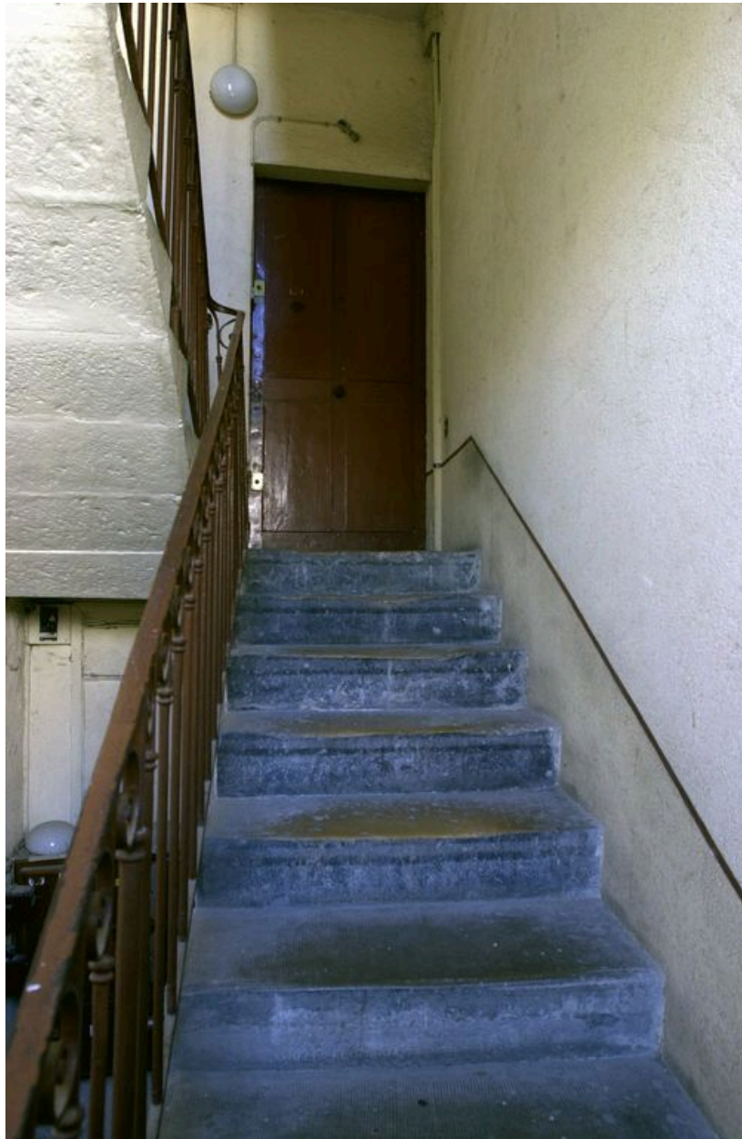
Deuxième volée de l'escalier
