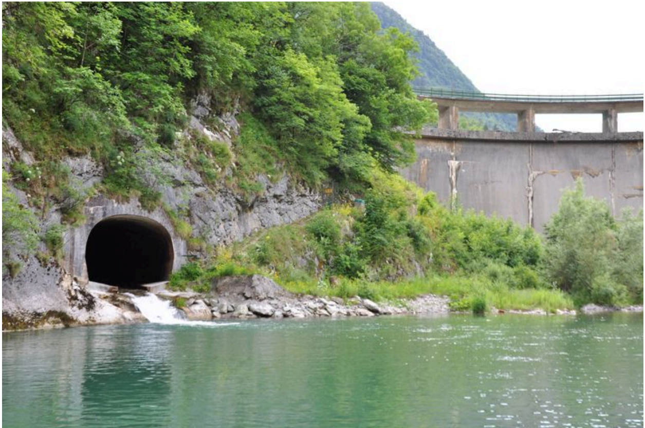
Vue de la galerie de dérivation
