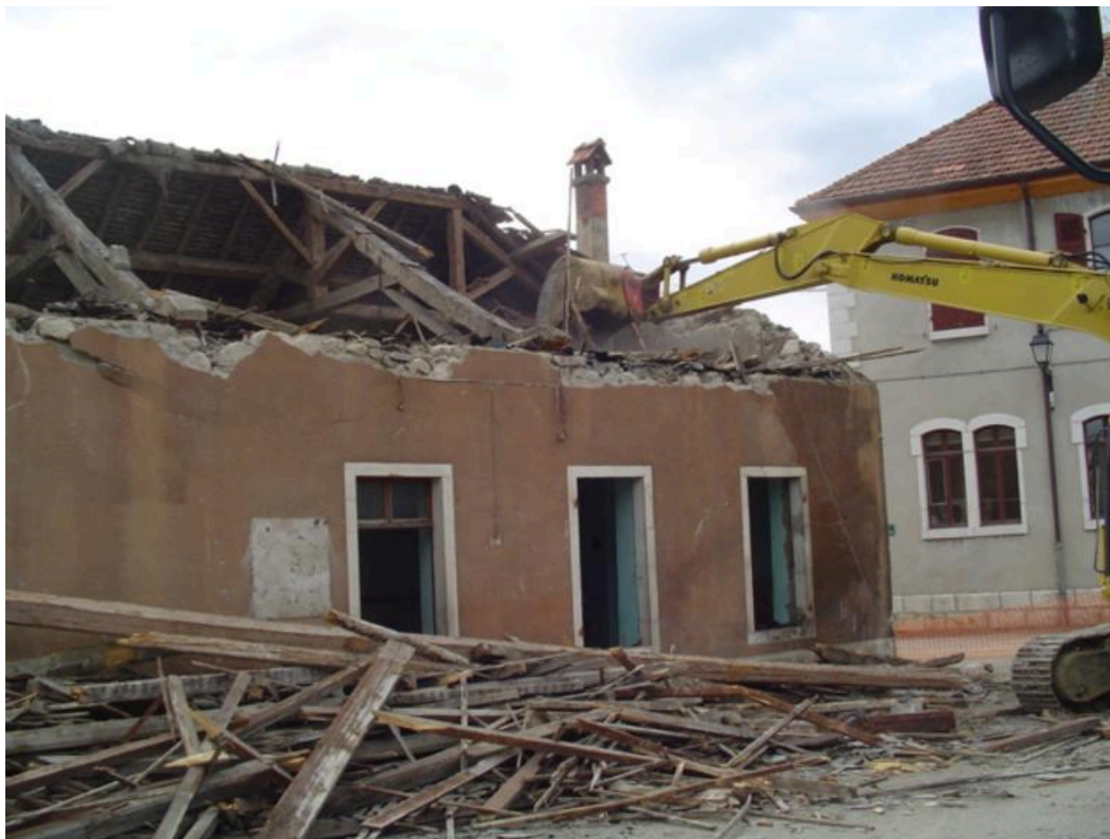
Vue de la démolition de l'ancienne école, en 2005 (A. P. Cochet).
