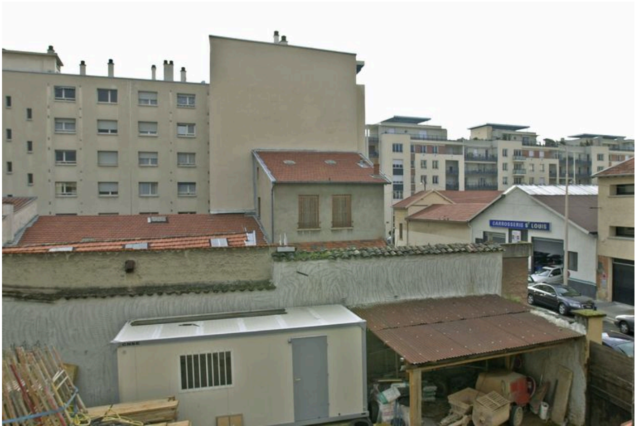
Emprise de la parcelle et haut de la façade sur cour, vues depuis la cage d'escalier du 15 rue Claude-Boyer à l'ouest
