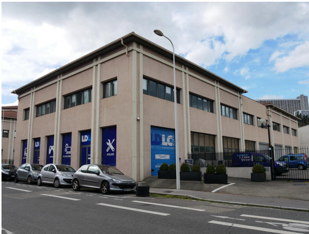
Vue ouest de l'usine Poizat
