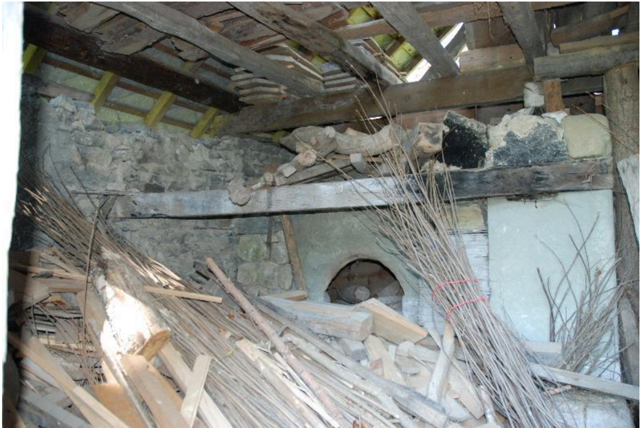
Vue partielle du four à pain.
