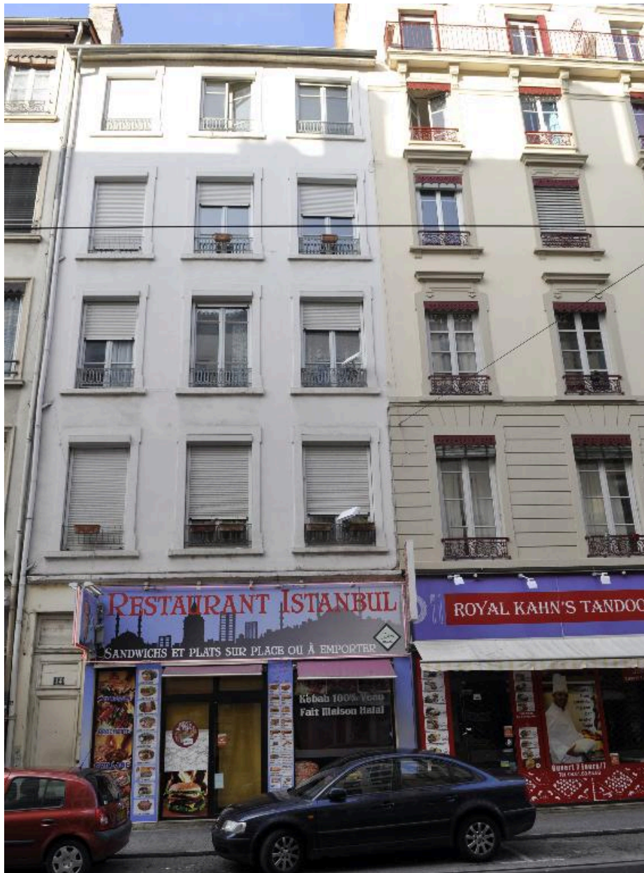
Vue générale de l'élévation sur rue
